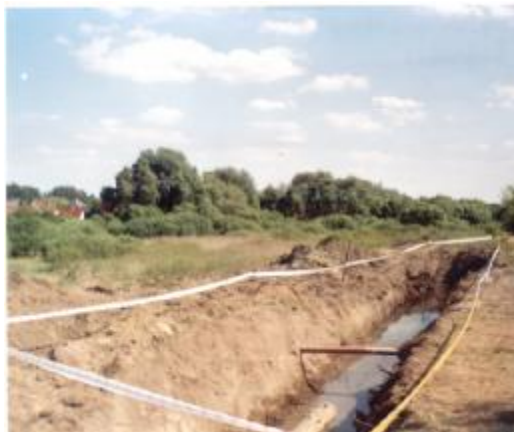
9. A Barátság I. kőolajvezeték rekonstrukciója az I vacsi-láprét északi részén (2003)
